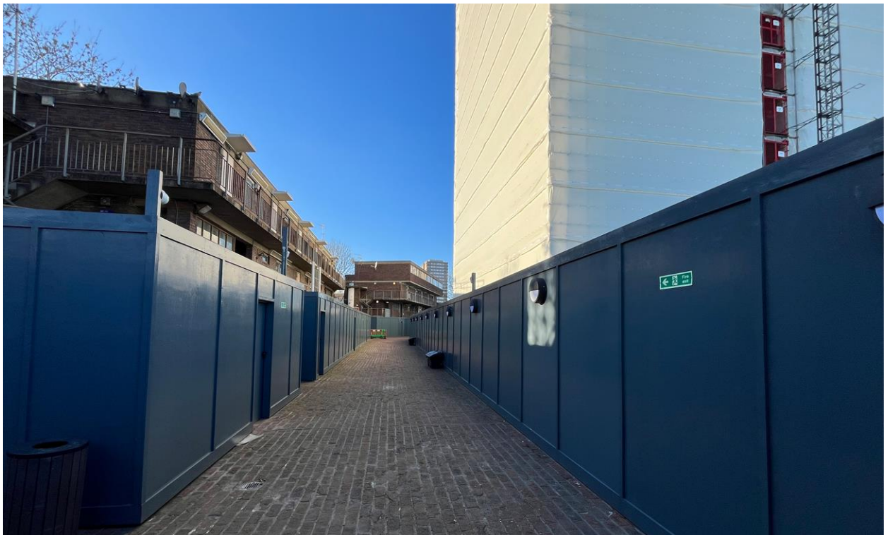
عکس محل شماره 12: بخش شرقی گذرگاه مرتفع گرنفل واک و نرده های موقت (24/01/18)
