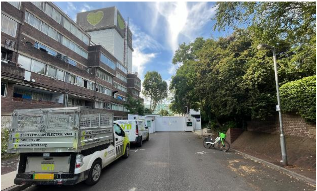
Fotografia 6 do local: Abordagem à Grenfell Road à entrada do local seguro (06/07/23)
