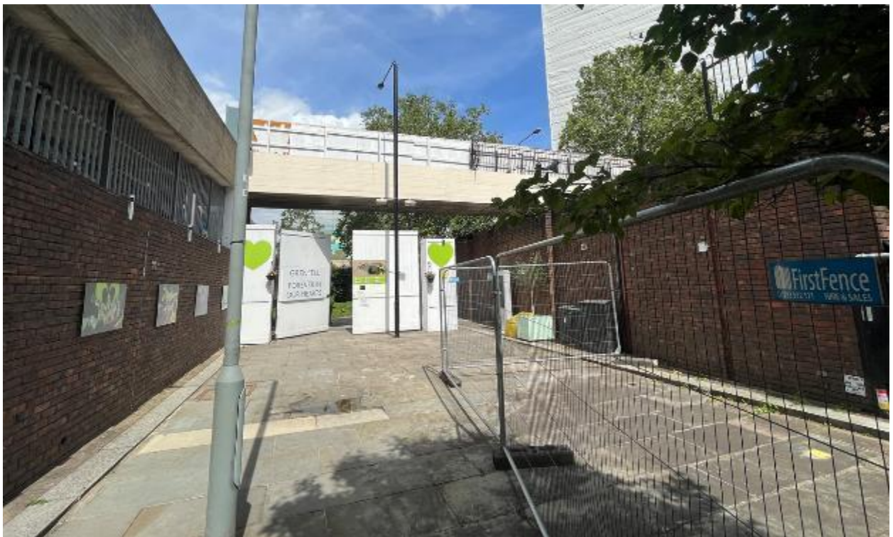
Fotografia 2 do local: Vista no topo da Station Walk na entrada do local segura (06/07/23)
