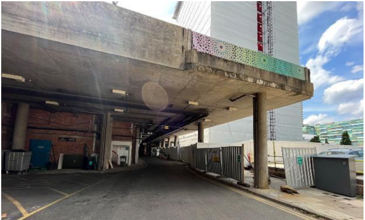
Fotografia 5 do local: Estrada de serviço coberta em limites sul do local do memorial (06/07/23)
