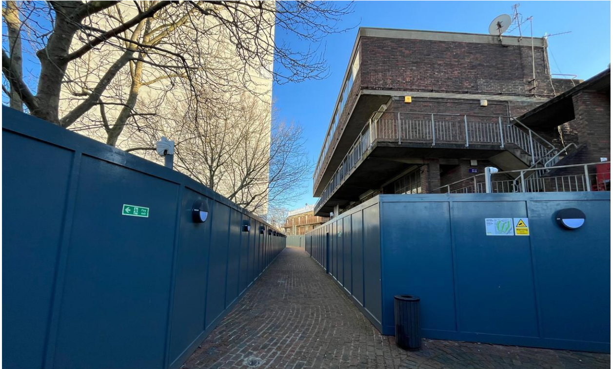
Fotografia 11 do local: Secção ocidental de Grenfell Walk com passeio elevado e vedação (06/07/23)
