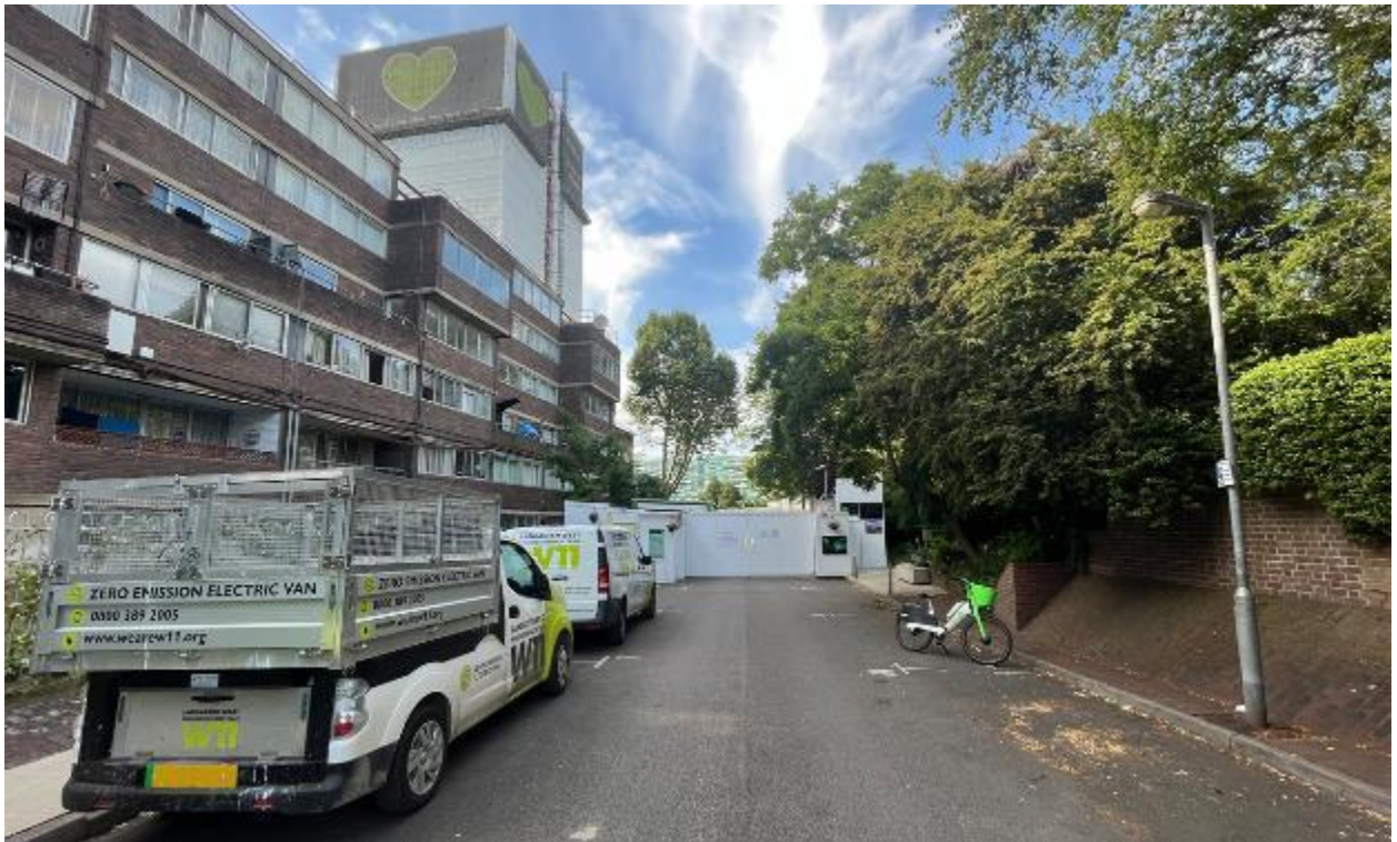
ሰፈር ስእሊ.6: Grenfell Road ናብቲ ዉሑስ መእተዊ ስፍራ ዝቀርብ(06/07/23)
